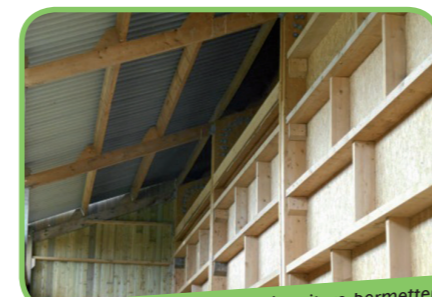
70 cm d'épaisseur sous la toiture permettent à l'air de se réchauffer
